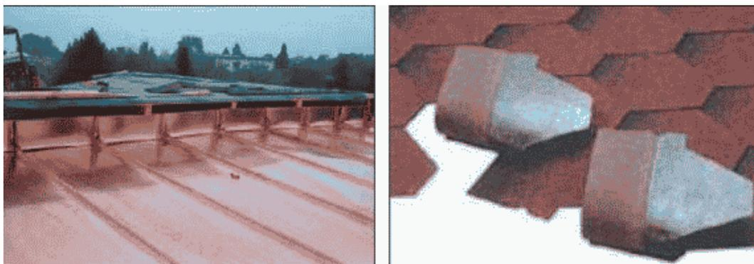
Устройство фальцевых кровель производится по сплошному основанию или по обрешетке (рис. 7).
